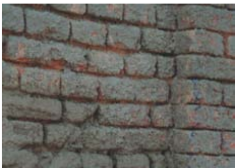
Síťovitě provedený kotvící postřík
