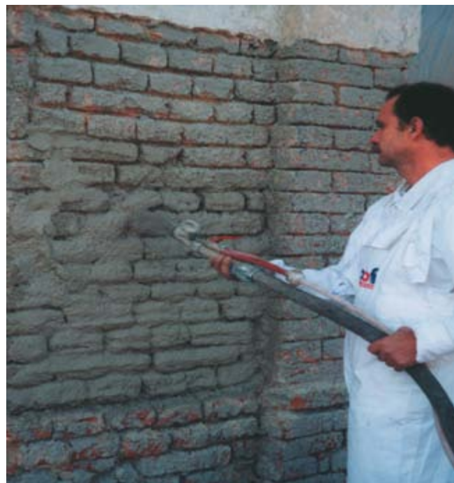
Strojní aplikace vyrovnávací vrstvy
