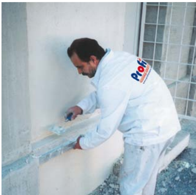
Ruční aplikace Profi Poretec WTA Sanierplus
