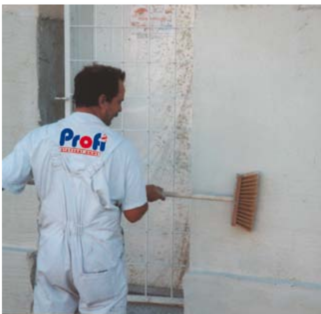
Zdrsnění povrchu omítky
