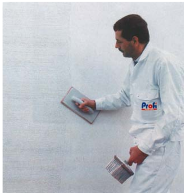
Provedení povrchové úpravy
