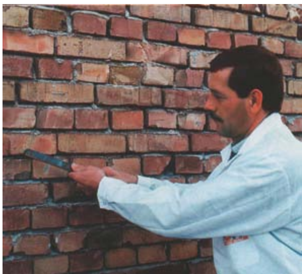
Příprava podkladu - proškrábnutí spár
